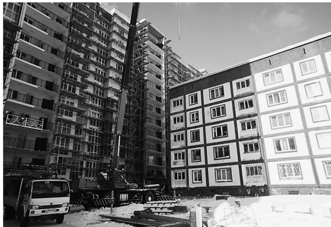
古いPC造共同住宅と新築RC造共同住宅
